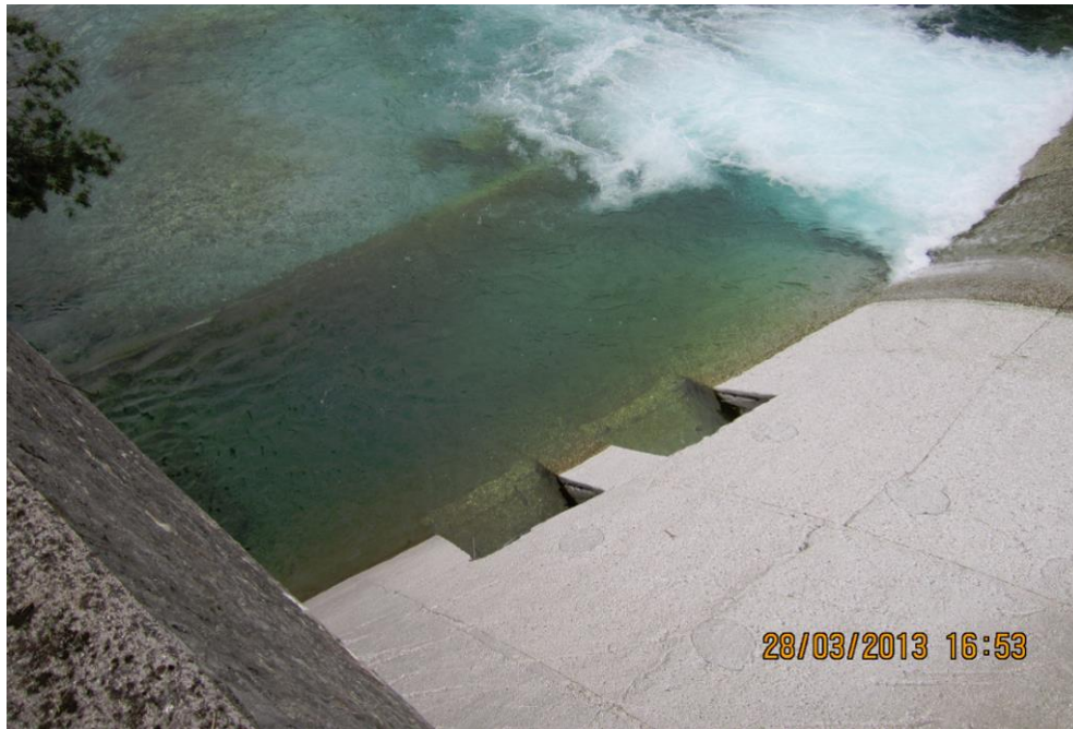
Figura 6: le bocche con funzione sghiaiatrice esistenti sulla traversa. Nel progetto si prevede la loro pulizia e il ripristino della funzione originaria. Verrà posto in opera un accorgimento (salto di fondo da 80cm di altezza alla bocca sghiaiatrice) in modo da garantire al meglio l'impedimento alle specie alloctone di risalire anche accidentalmente l'opera. L'impossibilità di risalita durante le manovre di pulizia (unico momento in cui le paratoie sghiaiatrici verranno aperte) verrà ad essere garantito anche grazie alla velocità di scarico delle acque (superiore ai 4m/s)
