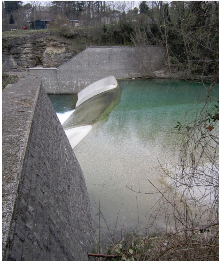
Figura 10: Traversa esistente con in primo piano l'ala della briglia dove si prevede la realizzazione dell'impianto di progetto.
