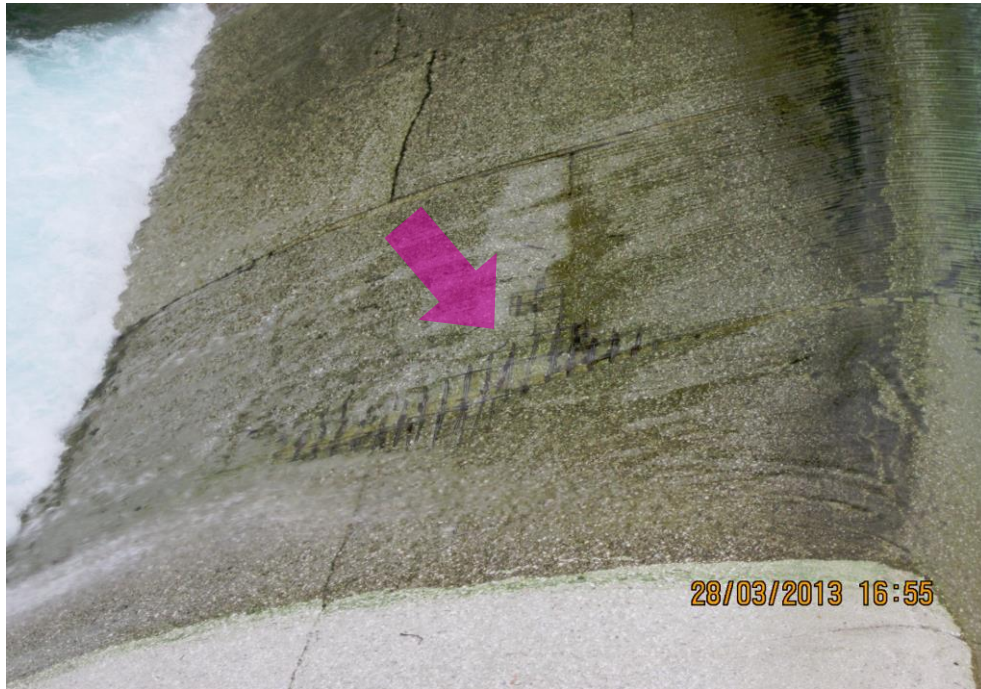
Figura 1: evidenti erosioni con esposizione delle armature metalliche della traversa esistente (anno 2013).
