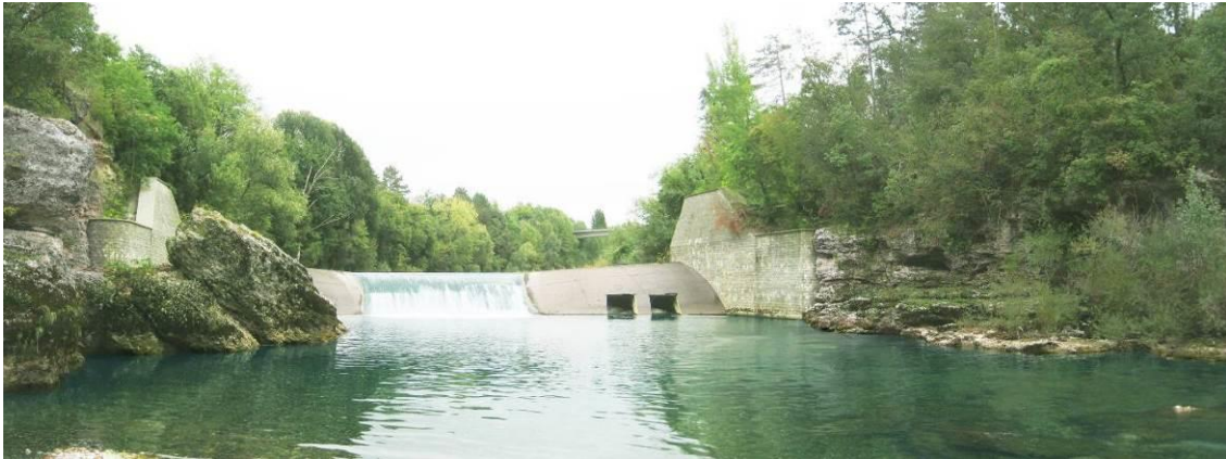
Figura 11: stato di fatto ripreso da valle
