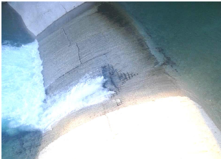
Figura 2 – la situazione nello stesso punto nel 2016. L'erosione della gaveta sta avanzando con incremento dell'esposizione delle armature e parziale distruzione delle stesse. Risulta necessario un intervento manutentivo.
