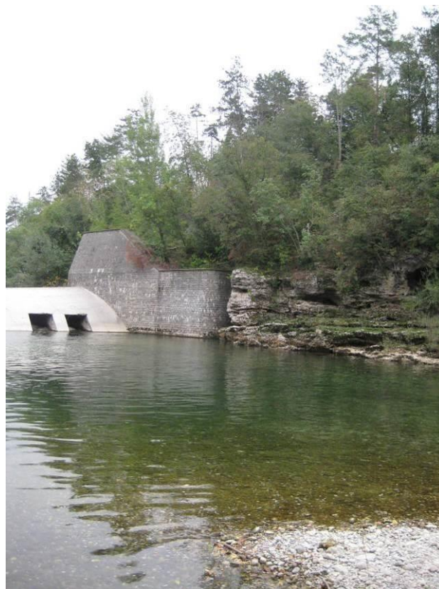
Figura 8 – Nell’immagine di destra: la briglia in oggetto vista dalla sponda in sinistra orografica. Immagine di sinistra: la briglia vista da valle con in evidenza la muratura a tergo della quale viene ad essere realizzata l’opera di progetto, completamente interrata ed invisibile.
